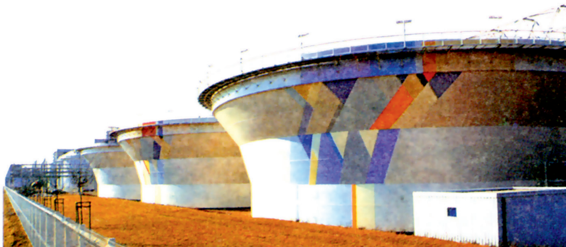
Εικόνα 10-1. Εγκαταστάσεις καθαρισμού αποβλήτων βιομηχανίας στο Bitterfeld (Γερμανία).
