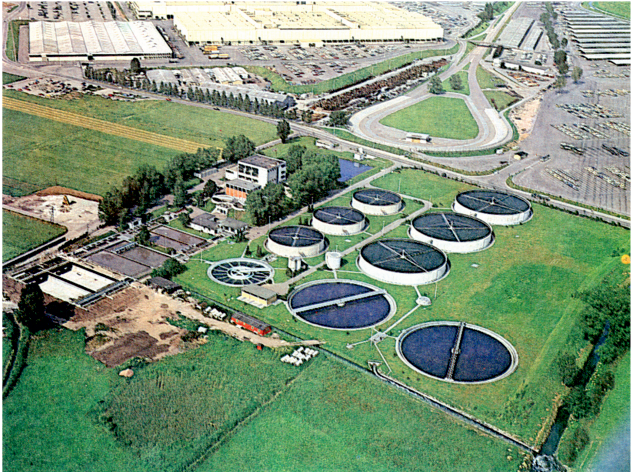
Εικόνα 10-2. Εγκαταστάσεις επεξεργασίας οικιακών λυμάτων και αποβλήτων της αυτοκινητοβιομηχανίας Daimler Benz στη πόλη Sindelfingen (Γερμανία).
