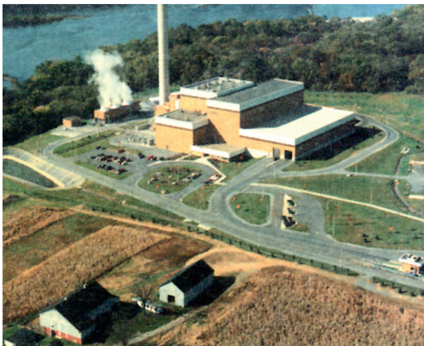
Εικόνα 10-6. Εργοστάσιο επεξεργασίας απορριμμάτων στο Lancaster της Pennsylvania.
