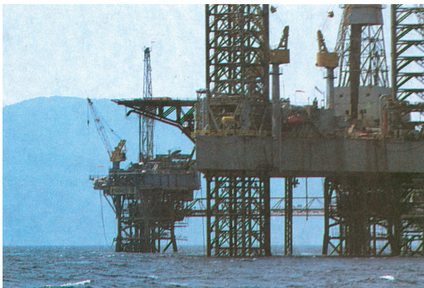
Εικόνα 9-3. Εξέδρα άντλησης πετρελαίου στον Πρίνο. (Πηγή: Κ. Μπόγδανος)
