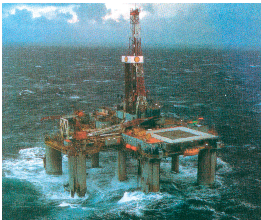
Εικόνα 9-5. Εξέδρα άντλησης φυσικού αερίου στη Βόρειο Θάλασσα.
