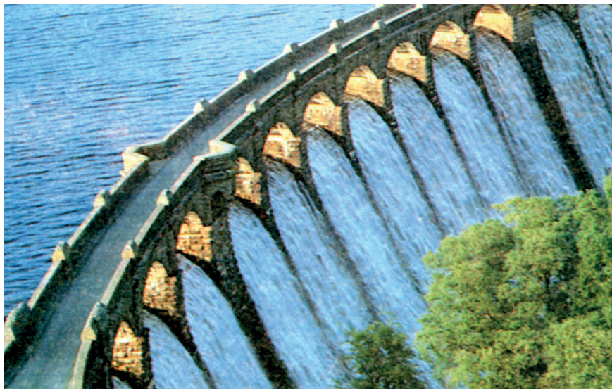
Εικόνα 9-8. Φράγμα CRAIG GOCH για παραγωγή ηλεκτρικής ενέργειας στην Ουαλία.
