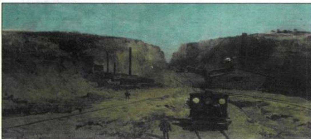
Η διάνοιξη της διώρυγας της Κορίνθου
