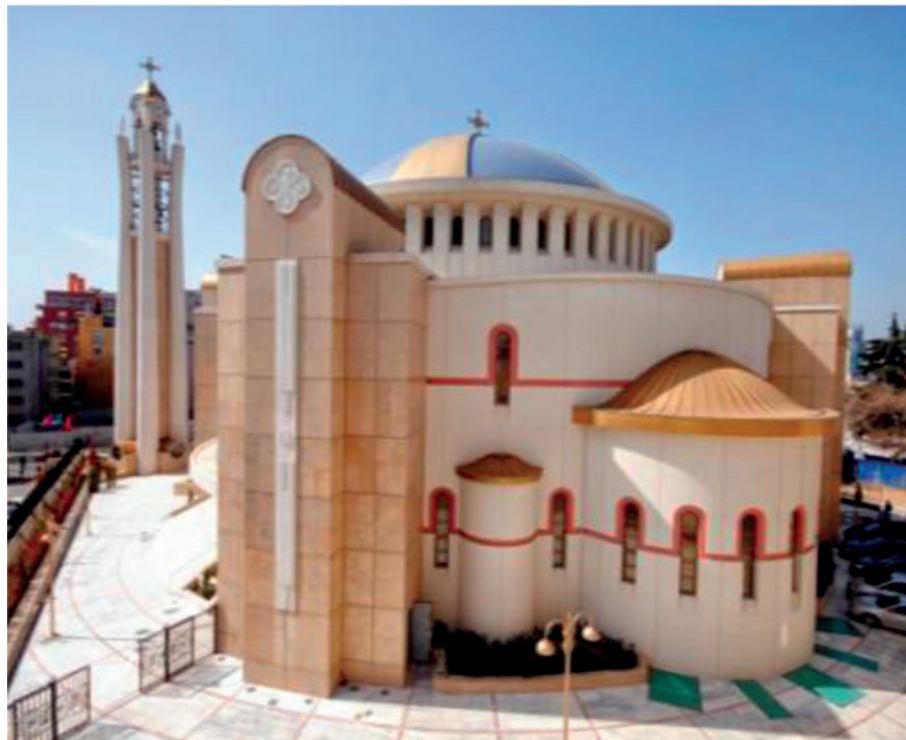
Ναός της Αναστάσεως, Τίρανα
